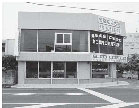
交差点角の落ち着いた外観
